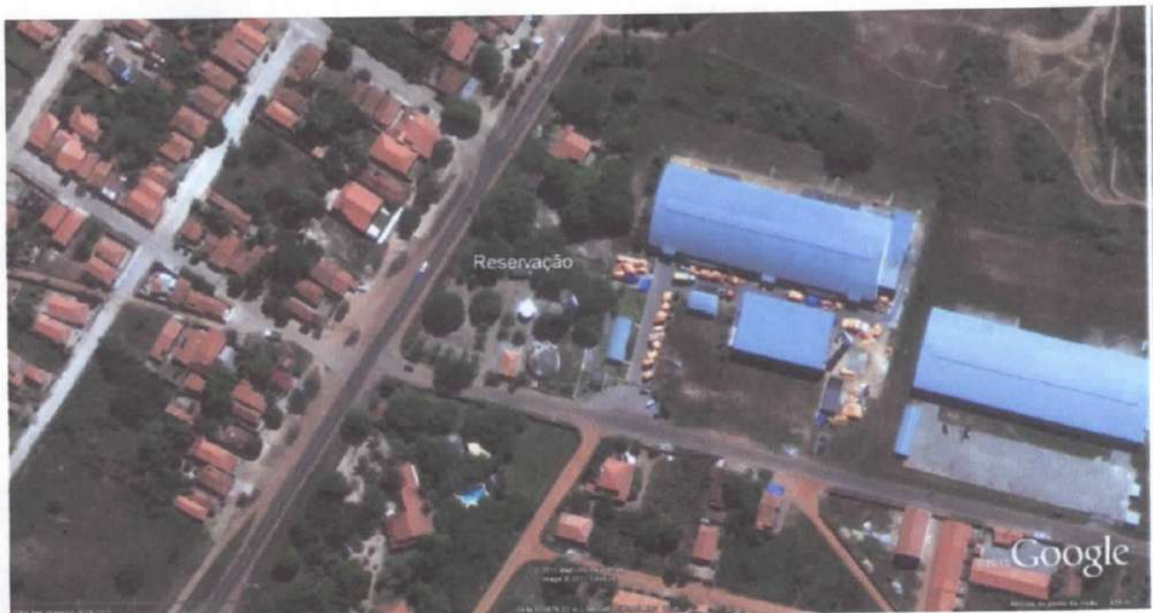
Figura 5-4: localização da Reservação de água potável do distrito Sede. Fonte: CONEN, sobre imagem do Google Earth.
