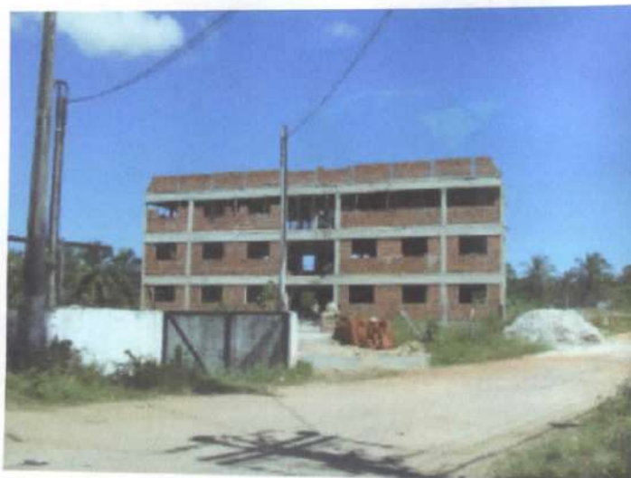
Figura 4-25: construção em Pecém. Autor: FRANCO, 2011.
