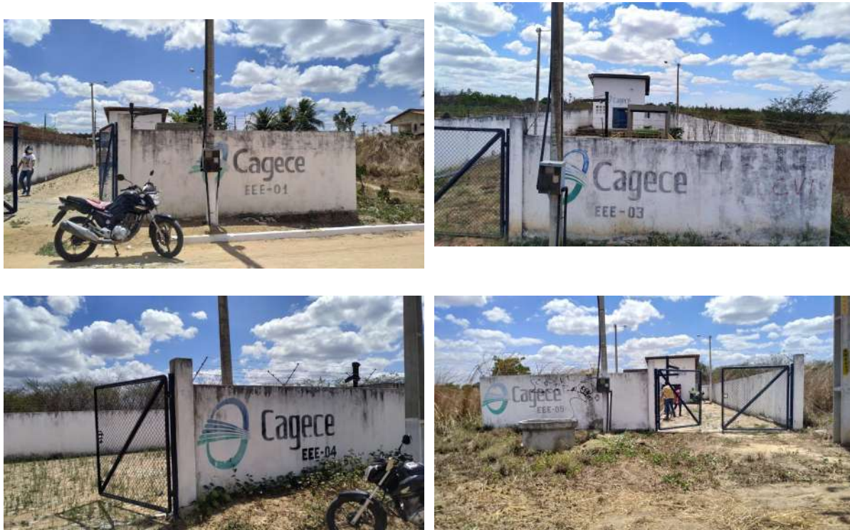
Figura 81: Fachada das Estações elevatórias de esgoto do distrito Croatá.
