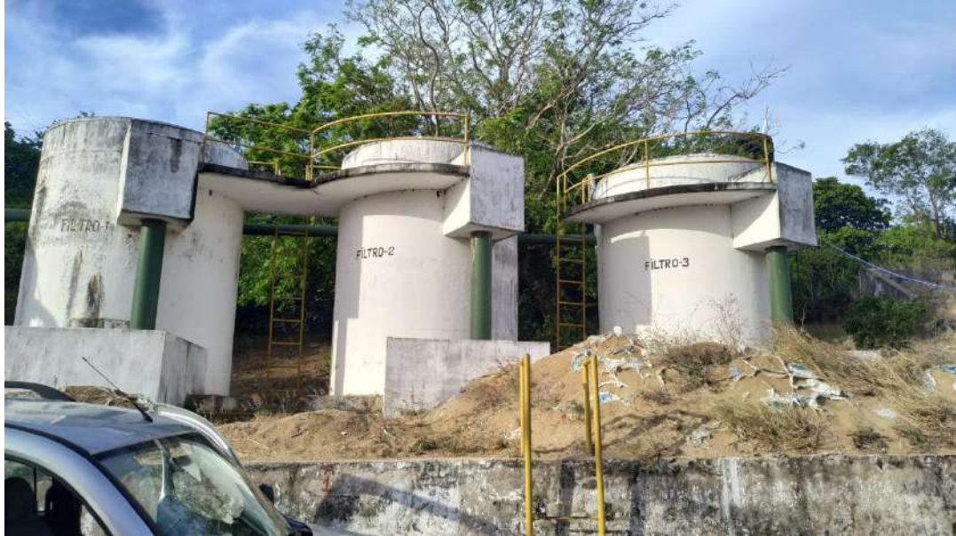
Figura 48: Unidade de filtração de fluxo ascendente.
