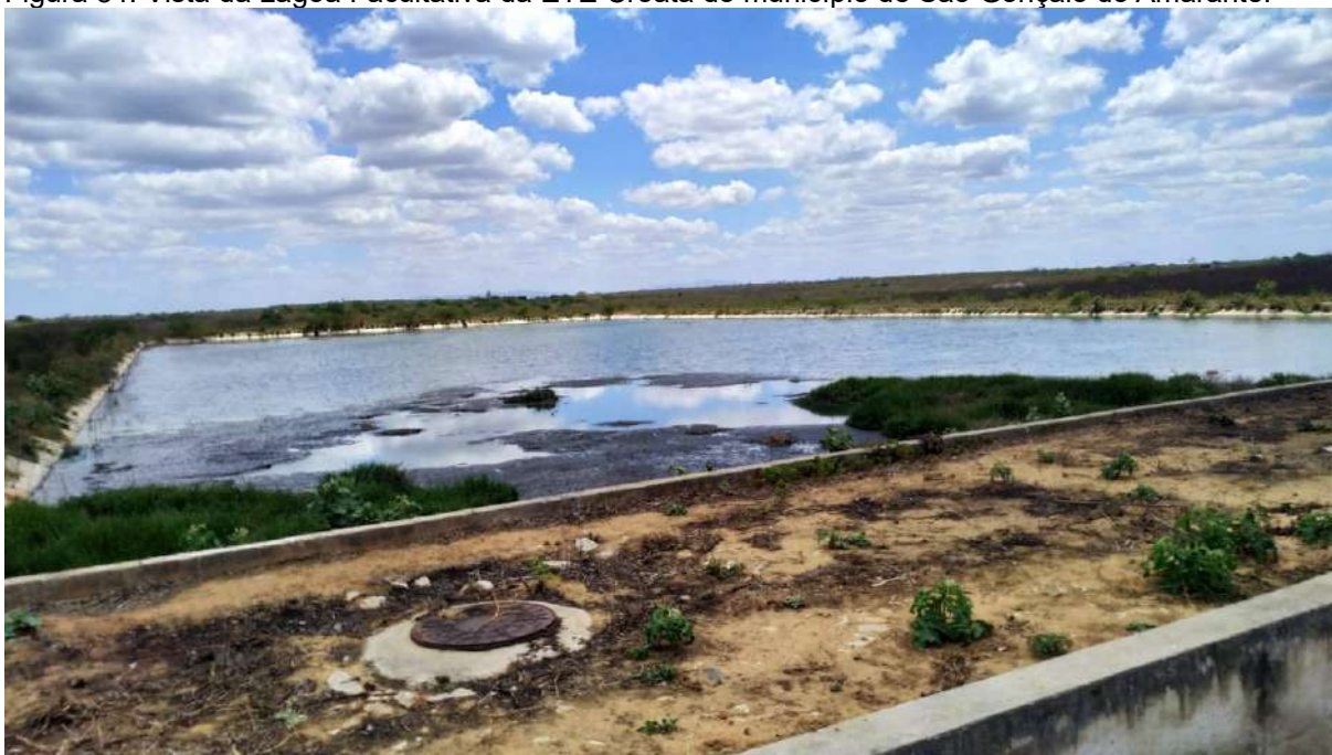
Figura 84: Vista da Lagoa Facultativa da ETE Croatá do município de São Gonçalo do Amarante.
