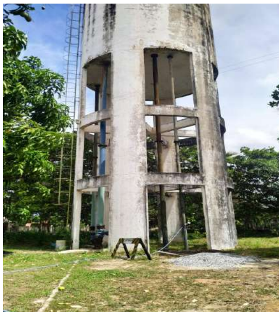
Figura 26: Reservatório elevado REL-03.
