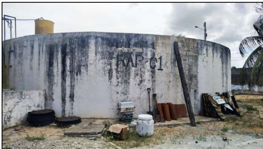
Figura 25: Reservatório apoiado RAP-01.
