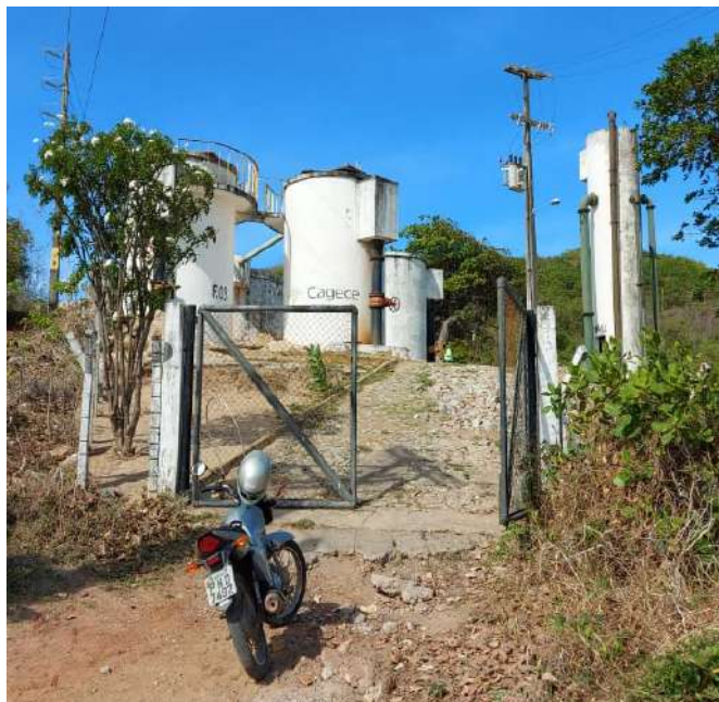
Figura 38: Fachada da ETA Pecém.
