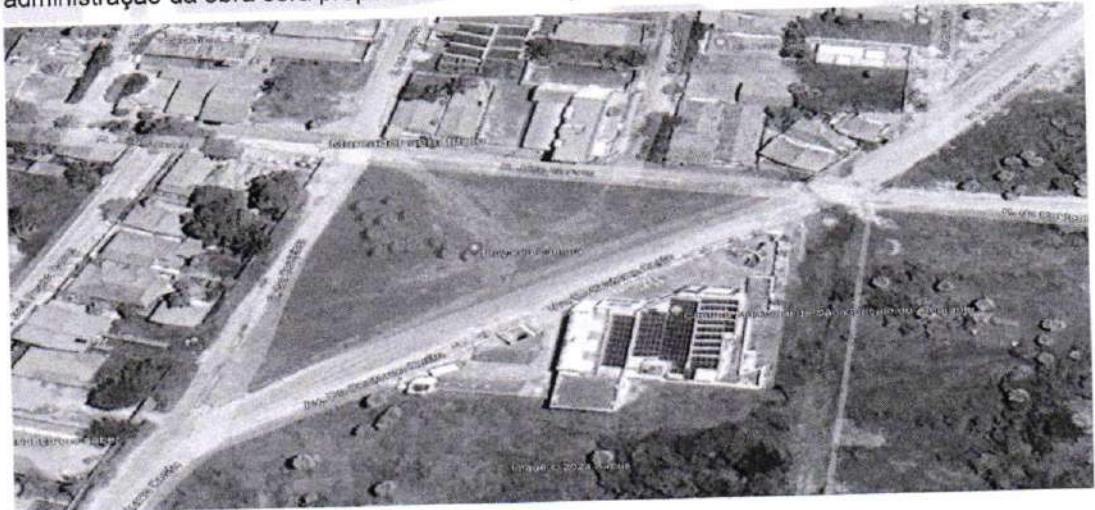
LOCAÇÃO DA OBRA
