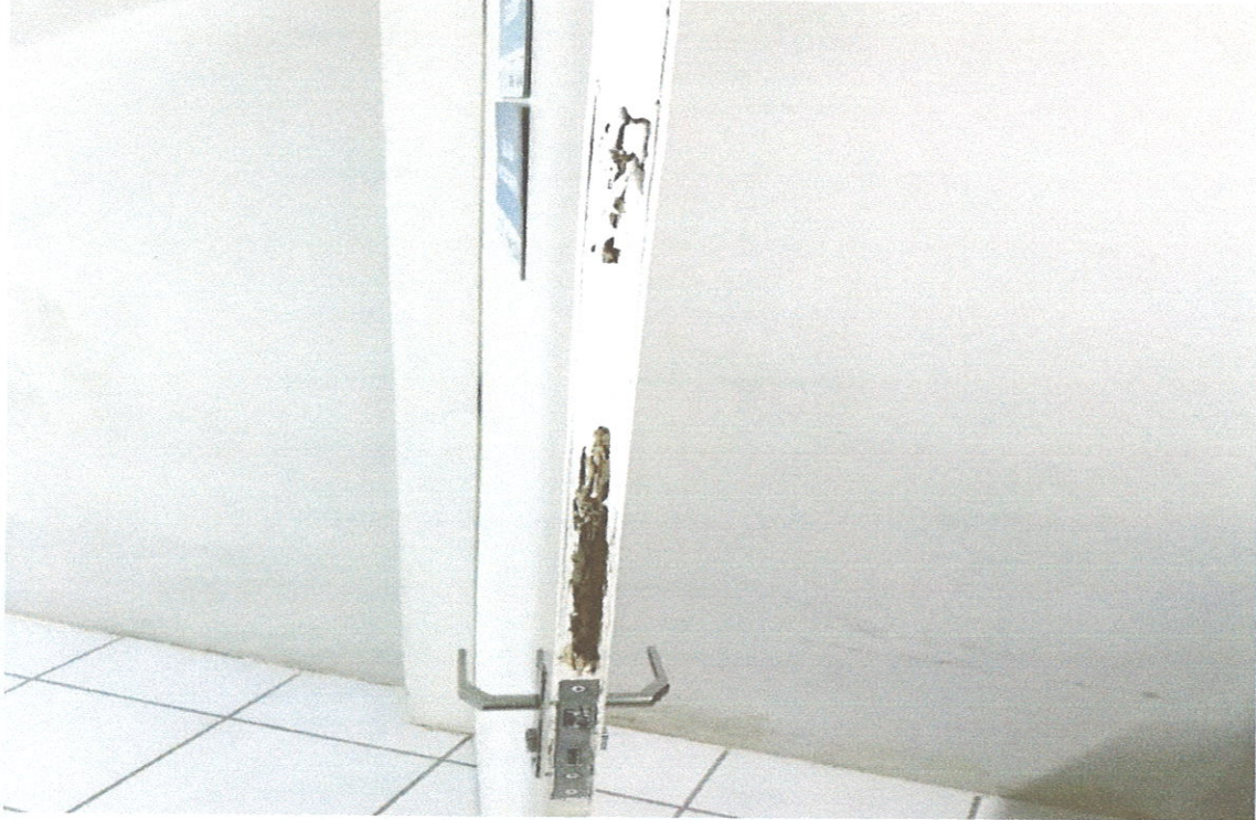
Foto 05- Vista do local onde será instalada porta nova e recebera correção o chapisco e emboço e revestimento cerâmico
