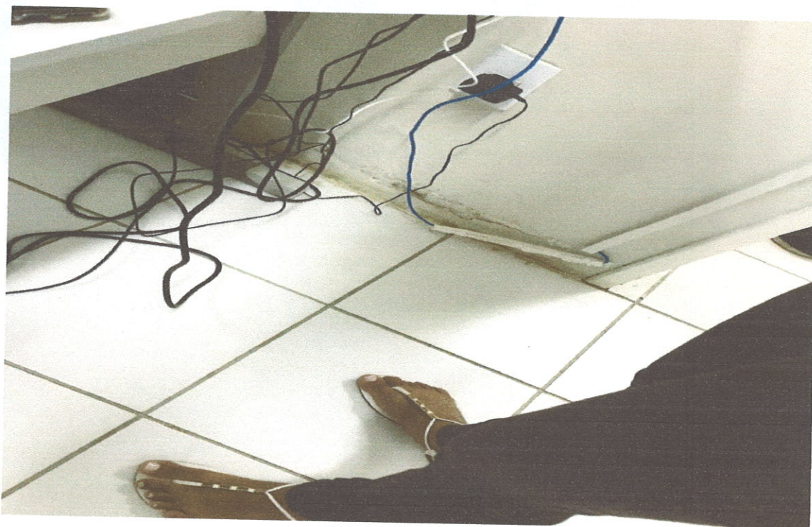
Foto 03- Vista do local onde será embutido o fio de rede e fixado tomada com caixa 2x4 e recebera revestimento cerâmico
