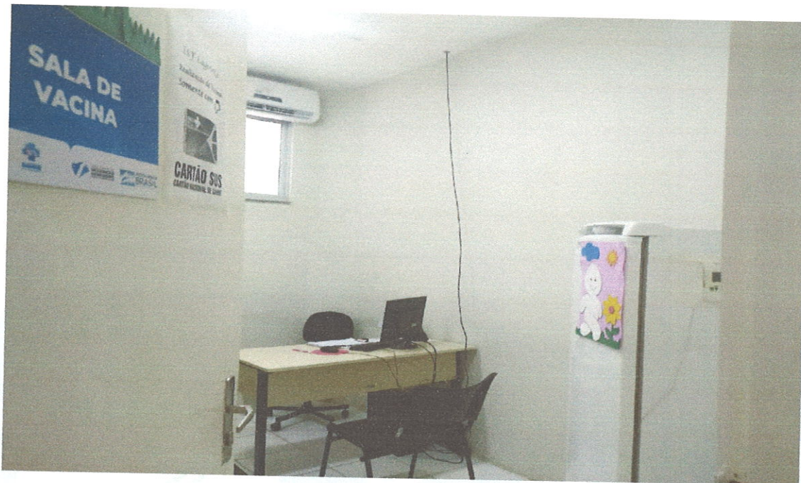
Foto 03- Vista do local onde será embutido o fio de rede e fixado tomada com caixa 2x4 e recebera revestimento cerâmico
