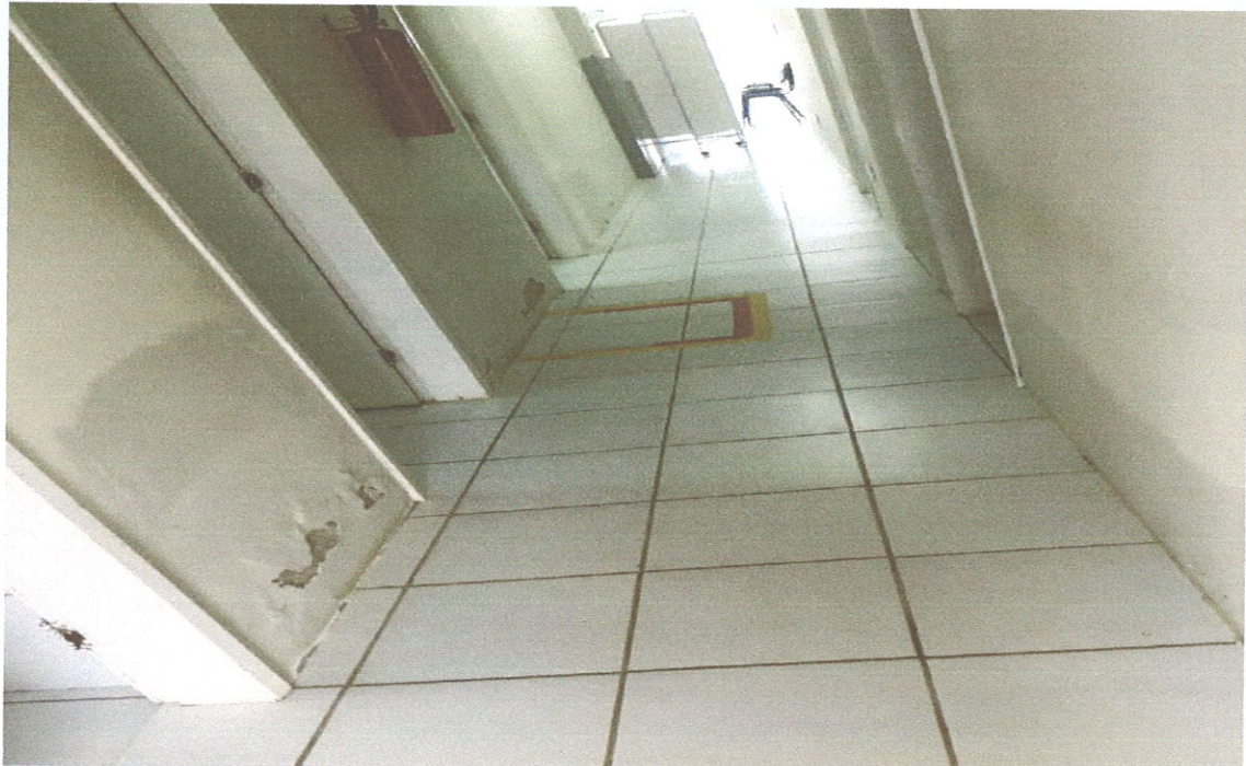
Foto 05- Vista do local onde será instalada porta nova e recebera correção o chapisco e emboço e revestimento cerâmico
